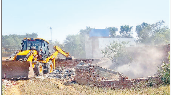
रेवाड़ी। सांपली में अवैध कॉलोनी का निर्माण तोड़ती जेसीबी।
